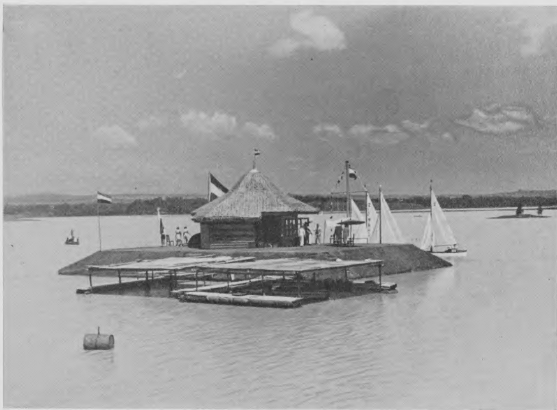
Waterreservoir (wadoek) Tengklik, waarvan de noorderdijk wordt gevormd door een natuurlijke heuvelrij; de kunstdijk bevindt zich aan de zuidkant (op de foto niet zichtbaar). Een eiland is „gefattoeneerd” tot een station voor zeilsport.
