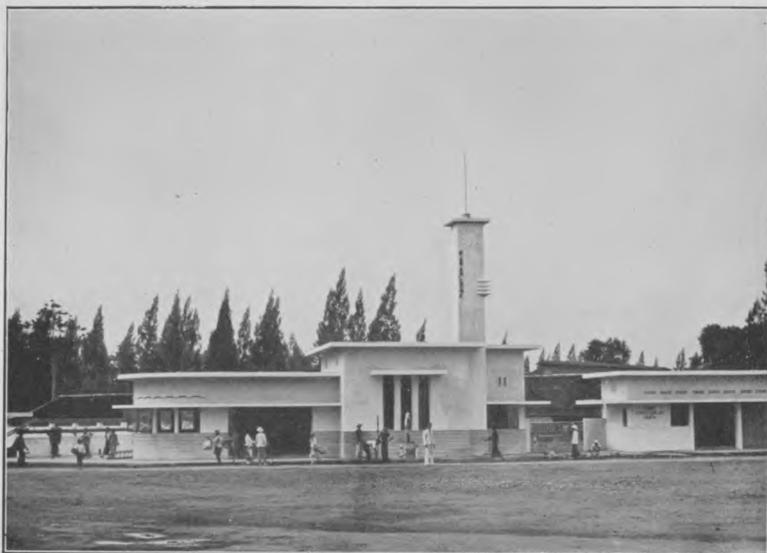
Uitbreiding en verfraaiing v. d. Pasar Legi, benoorden de Poera Mangkoenagaran. De eigenlijke pasarruimte bevindt zich achter een galarij van tokogebouwen, welke opengesteld zullen worden op den 16den Juni 1939
